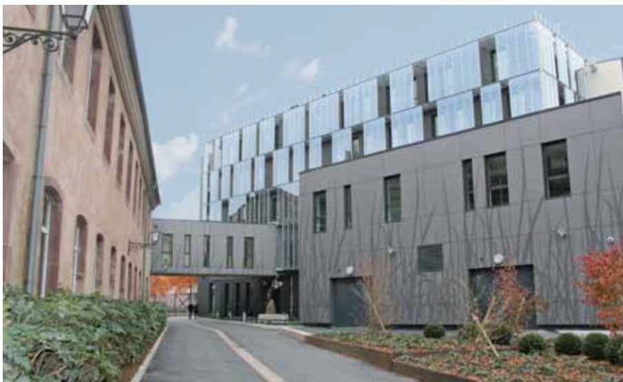
Nouveau bâtiment, allée Jacmel
