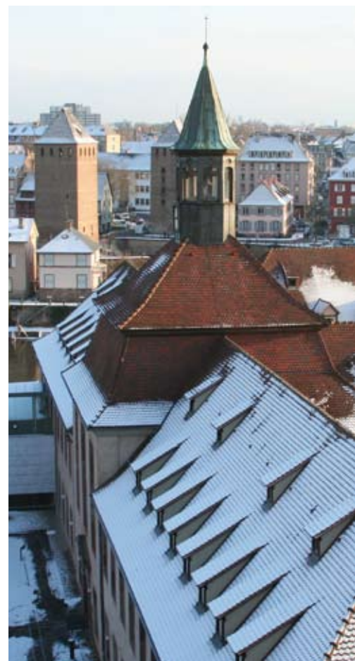
l ELENA vue depuis le nouveau bâtiment.
