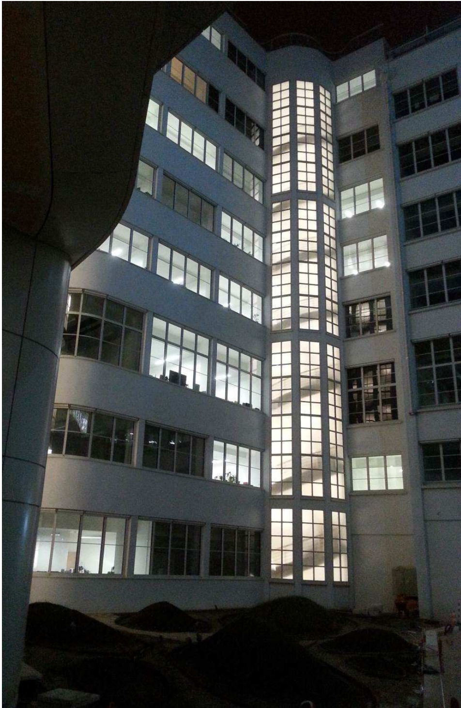
La cour de Fontenoy en travaux
